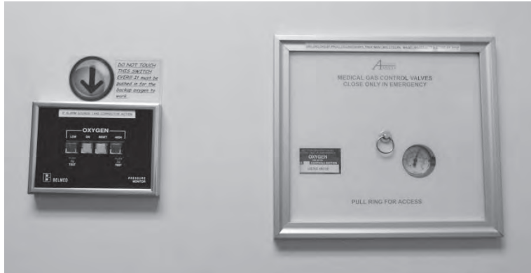
* 壁の酸素配備表示
